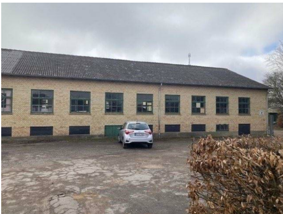
Facade mod Møllegårdsvej
