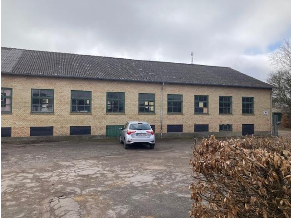
Facade mod Møllegårdsvej
