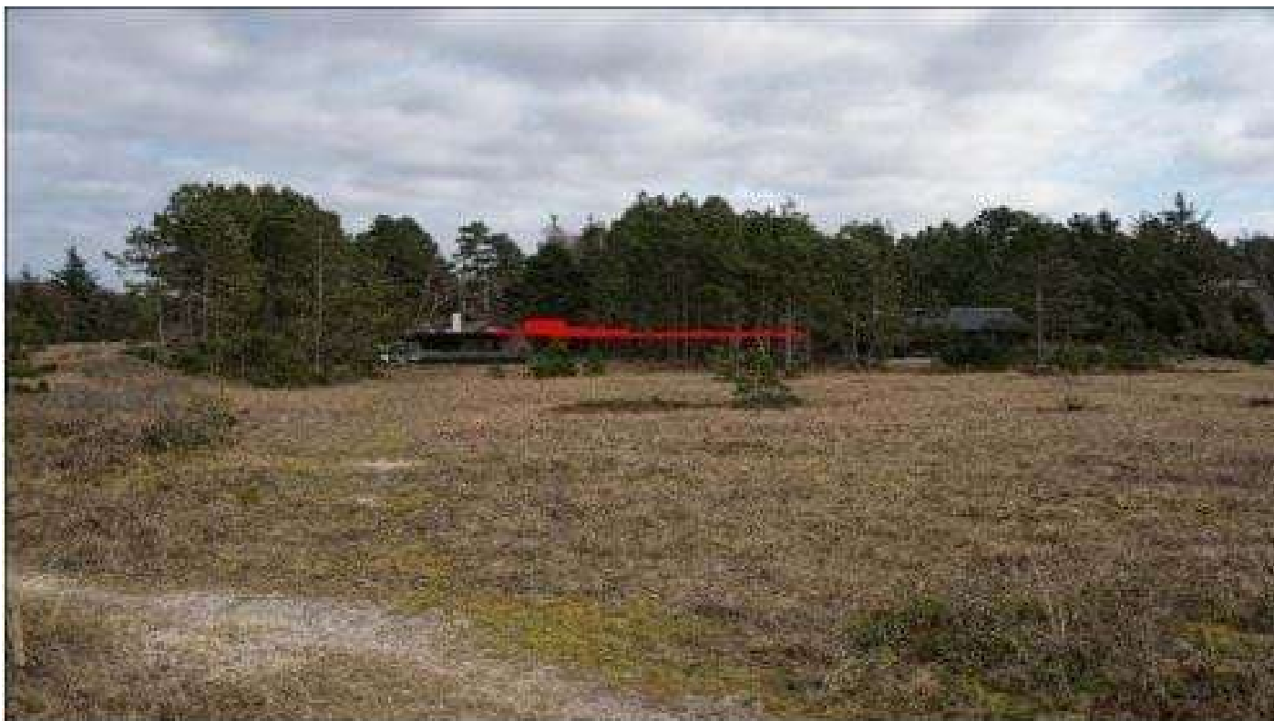
Anlæggets markering set fra visualiseringspunkt fra kysten ved Bjerger Sydstrand. Foto: NIRAS A/S.
